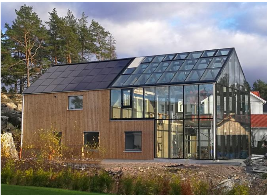
Szwecja - Budynek mieszkalny Roczna produkcja energii elektrycznej: 12 500 kWh
