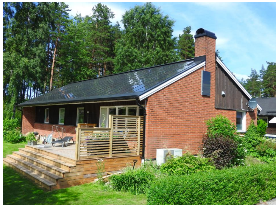
Szwecja - Budynek mieszkalny Roczna produkcja energii elektrycznej: 7 000 kWh
