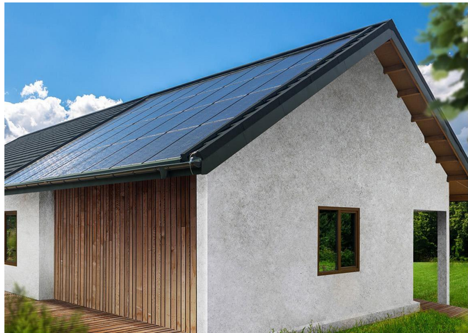
Mazury - dach SunRoof połączony z tradycyjną dachówką Roczna produkcja energii elektrycznej: 9 300 kWh
