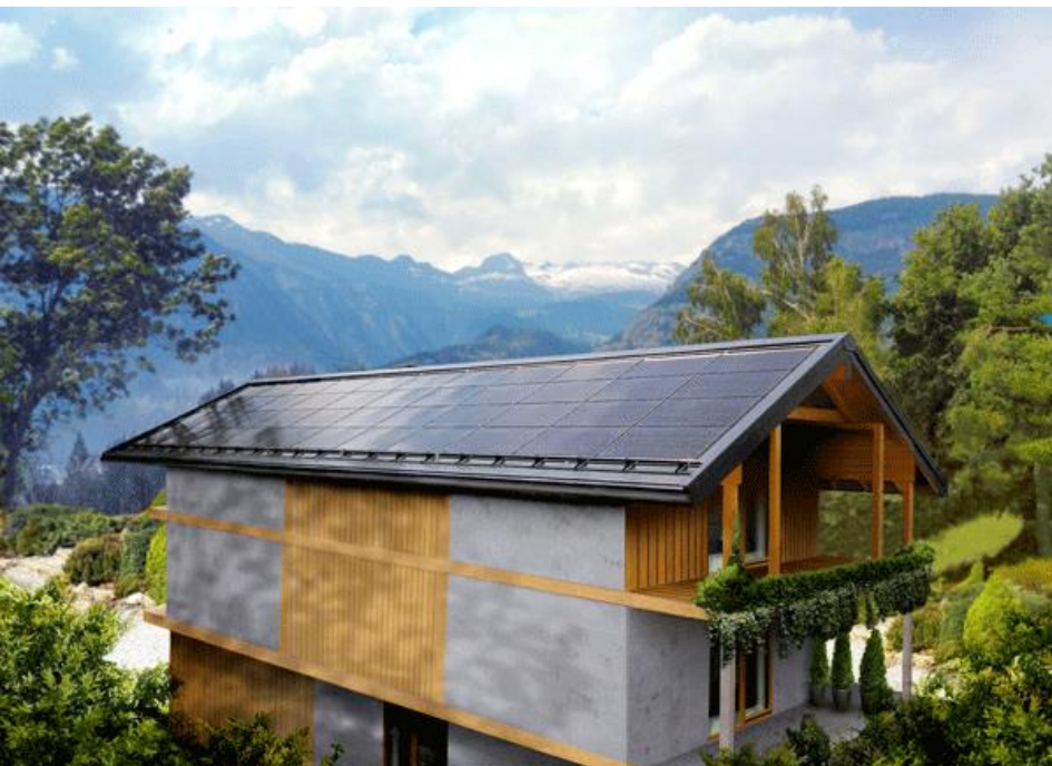
Termen, Szwajcaria - Budynek mieszkalny Roczna produkcja energii elektrycznej: 16 300 kWh
